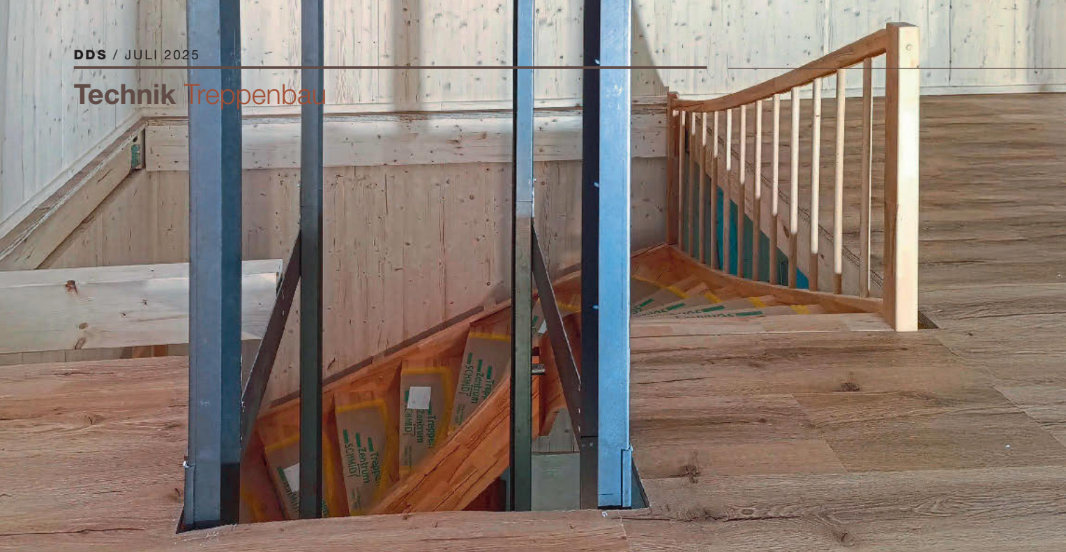
Eingebaute Hausliftkonstruktion im Treppenauge einer halbgewendelten Treppe. Die an den Innenraum angepasste Liftverkleidung kann bei Flexomobil durch den lokalen Partnerschreiner individuell erfolgen
