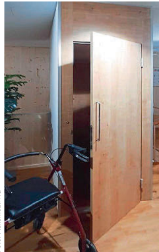
Vom Schreiner verkleideter Hauslift neben der Treppe
